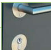
FLAT-Ausführung: Rosette wird in Aluminiumplatte eingefräst
